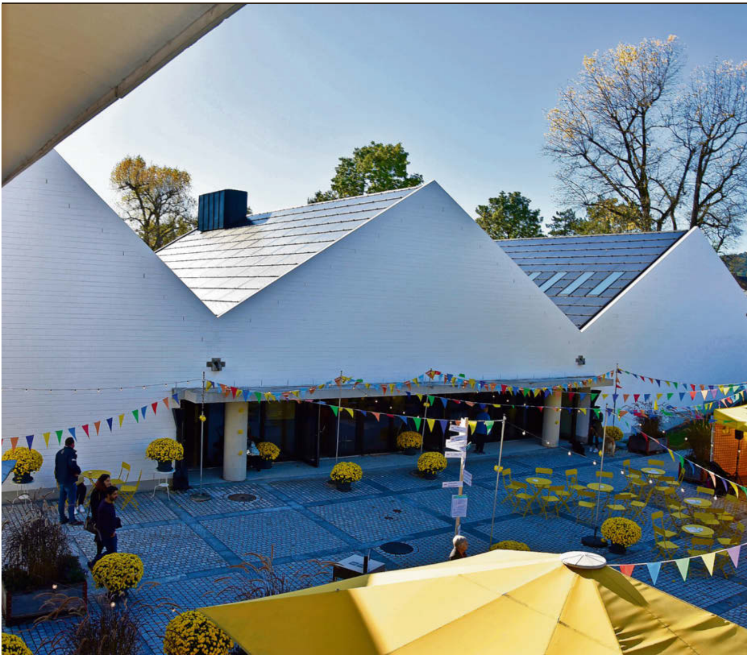
Mit einem Festakt wurde der Speicher bei der Oberen Mühle eröffnet. Von aussen fallen die markanten Giebedächer auf. Fotos: Marcel Vollenweider
